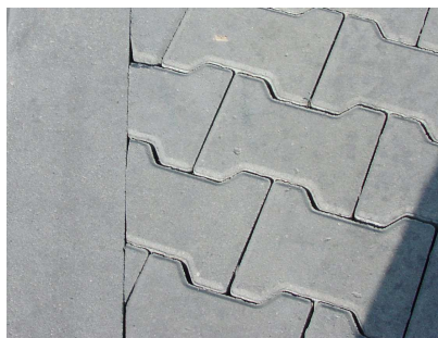
Fot.3-4 Detal łączenia kostki i krawężnika
